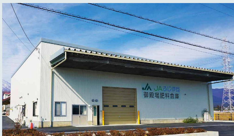
▲建物外観写真
