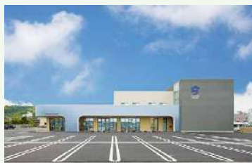
▲⑥JA遠州夢咲大坂支店・大城営農経済センター
