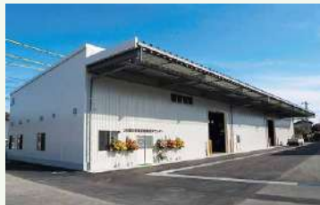
▲19 JA掛川市本所倉庫・営農センター
