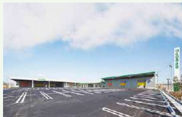
▲20 JAとびあ浜松西北営農施設
