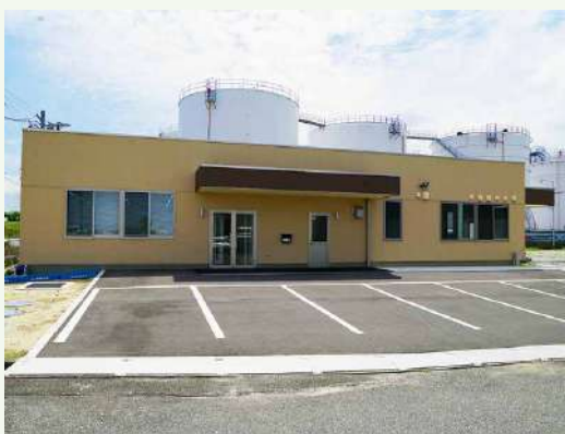
▲新事務棟外観
